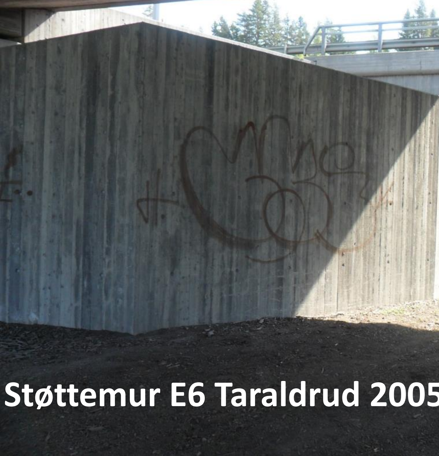
Prøveproduksjon med resirkulert tilslag
